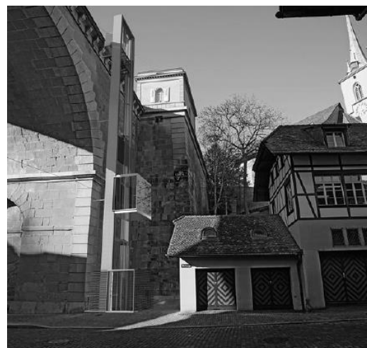
Der untere Eingang befindet sich in der Mattenenge. Die Liftkabine aus Glas und Chromstahl ist 1,40 x 2,30 m gross und fasst ca. 20 Personen. ©Walter Hunziker
